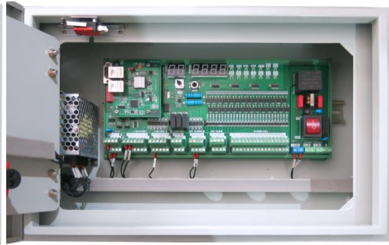
室控制终端内部
